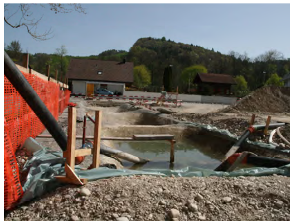
Abbildung 2 Baustellenentwässerung im Erdreich
