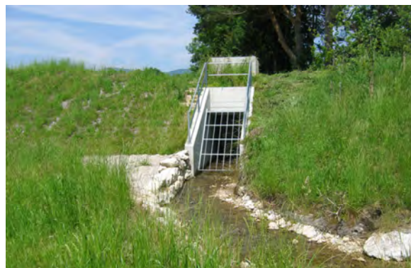
Abbildung 25 Mit einem Gitter gesicherte Eindolung
