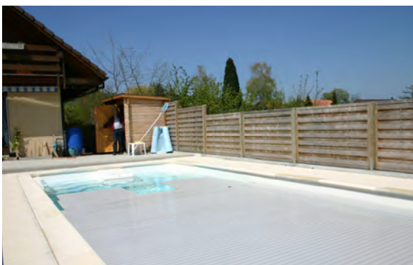
Abbildung 17 Schwimmbaddeckung mit Schlüssel, Schalter und Blickkontakt
